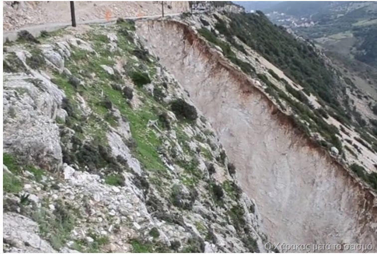
Χάρακας-Μύρτος, Κεφαλλονιά: Βραχώπτωση κατά τη σεισμική ακολουθία Ιανουαρίου 2014 [Πηγή: Κεφαλλονίτικα Νέα, 31 Μαρτίου 2014]
