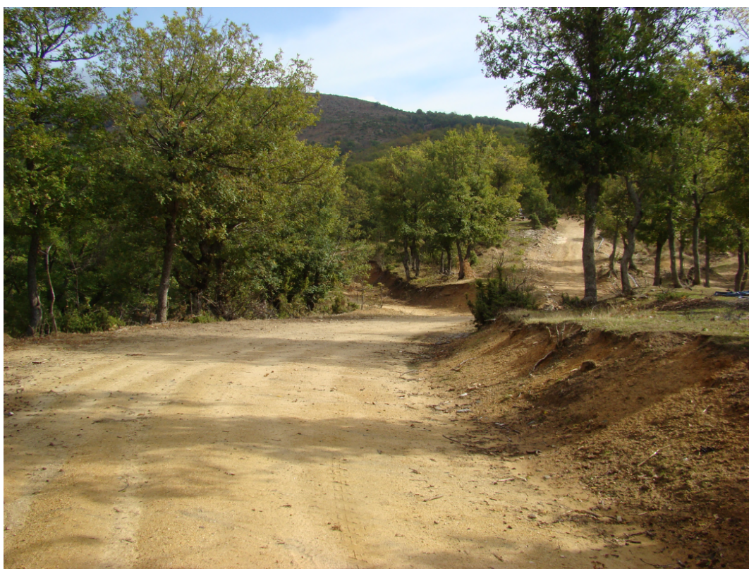
Φωτ. 8 Τμήμα υφιστάμενης οδού προς βελτίωση
