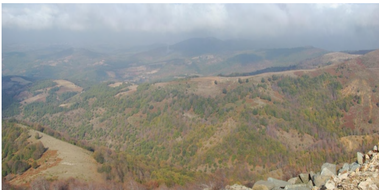
Φωτ. 4 Άποψη θέσεων εγκατάστασης των Α/Γ 4 & 5
