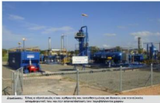
Συμπίεση: Όλος ο εξοπλισμός είναι κατασκευασμένος σε δοχεία για την εύκολη απομάκρυνσή του και την αποκατάσταση των περιβάλλοντα χώρου.
